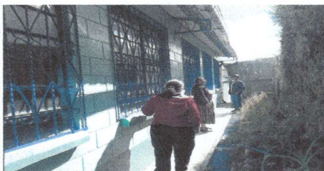
Foto 5. Fabricación e instalación de balcones. Módulo 2
