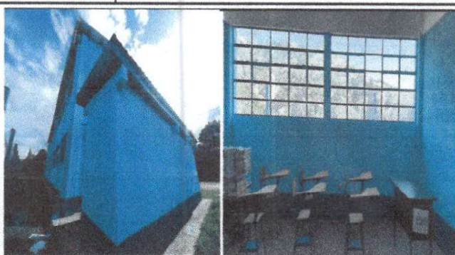
Foto 2. Pintura en muros exteriores e interiores. Módulo 3
