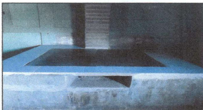
Foto 3. Sustitución de Plancha en Cocina
