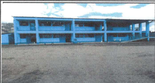
Foto 1. Mantenimiento a estructura de Puertas (reparacion y pintura) Módulo 3
