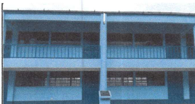
Foto 6. Mantenimiento a barandas. Módulo 3
