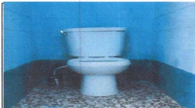
Foto 4. Instalacion de accesorios en inodoros en módulo de baños
